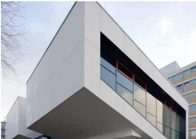
Фасадные панели лектория Рейнско-Вестфальского технического университета в г. Ахен, Германия
