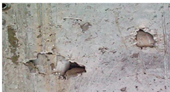
Полости от зависания бетонной смеси
