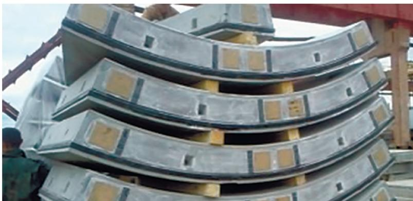
Рисунок 4.7. Высокоточные железобетонные блоки с резиновым контуром, предназначенным для уплотнения стыков изделий при возведении сборных водонепроницаемых обделок
