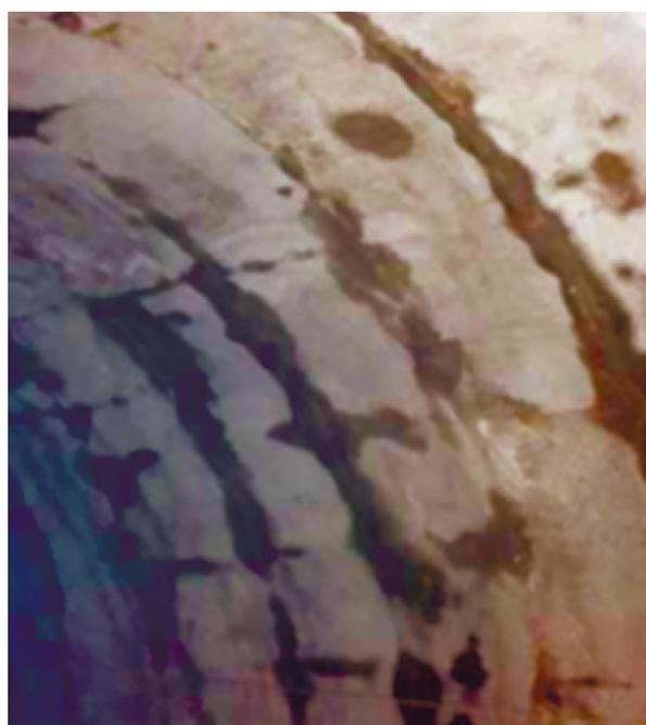
Рисунок 4.1. Дефекты бетонной поверхности конструкций тоннельных обделок, возведенных из монолитного бетона
