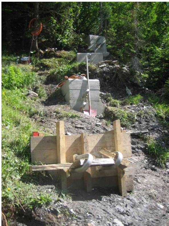
Гибкие оголовки с правильным наклоном. Наклон должен быть около \sim 45^\circ .
