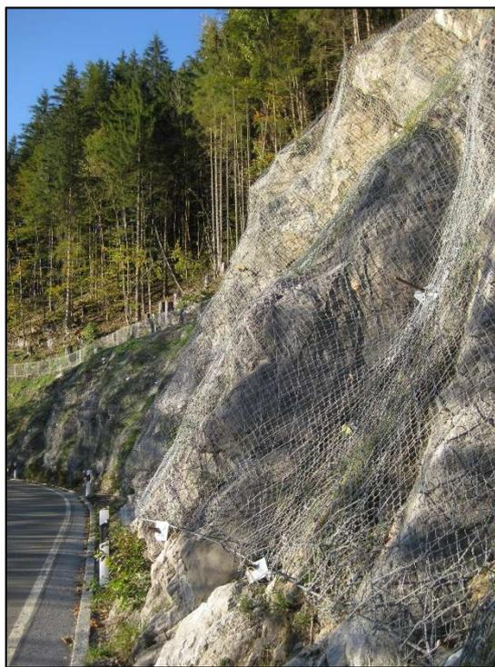
Рис. 1: Общая схема, проект, выполненный в Шпицинзее, Германия с использованием SPIDER® S3-130 и вторичной сети.
