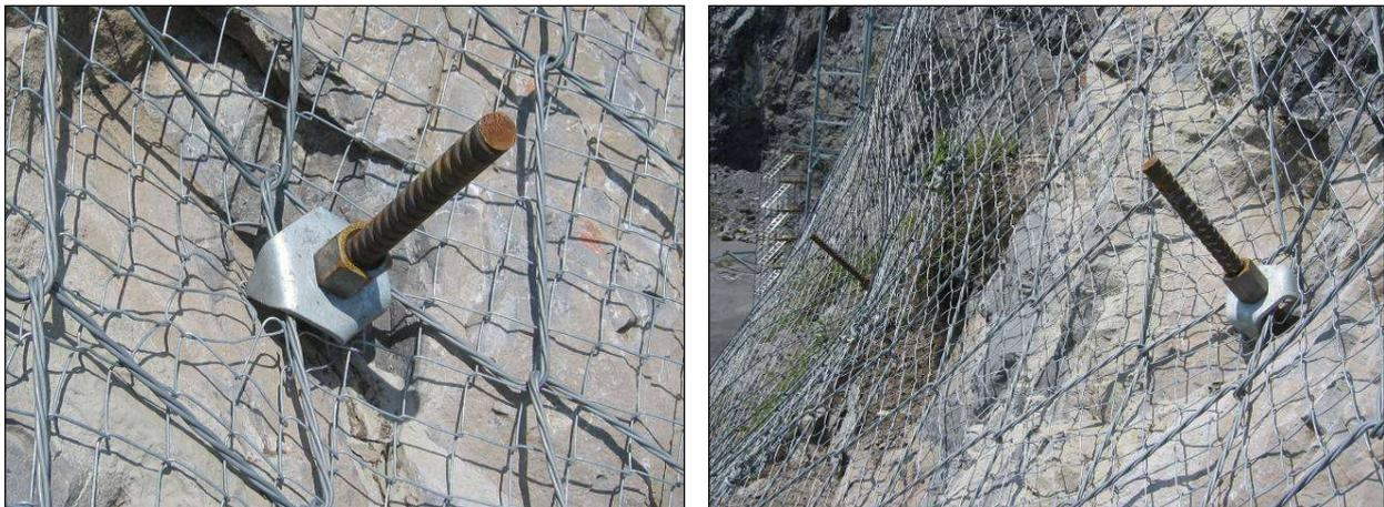
Рис. 12: Прижимной зубчатой пластины P11 (фото SPIDER® S4-230)
