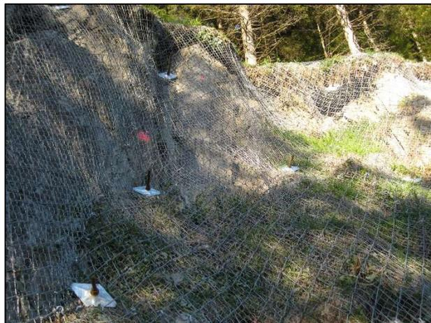
Рис. 4: Нагели на складе, нагели устанавливаются в углублениях оптимальным образом
