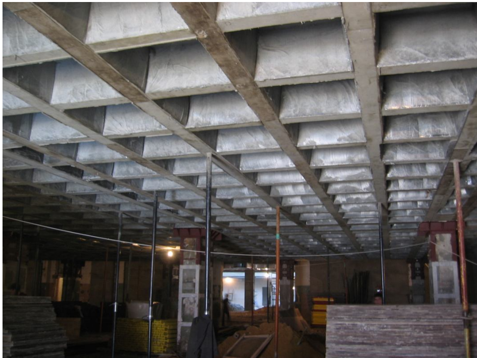
Рис. 3.14. вид кессонного перекрытия при использовании одноразовой картонной опалубки.
