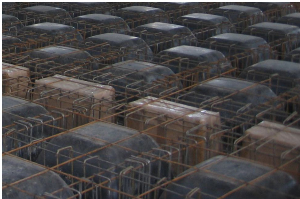
Рис. 3.12. Установка верхней арматуры каркасов 1-й очереди.
