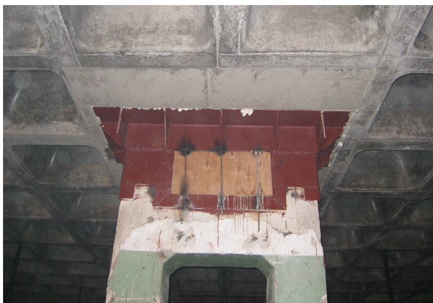
Рис. 5.1. Опорные площадки на существующих колоннах.
