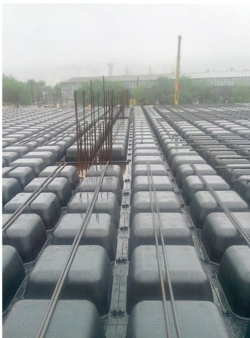
Рис. 3.3. Кессонная опалубка второго типа.
