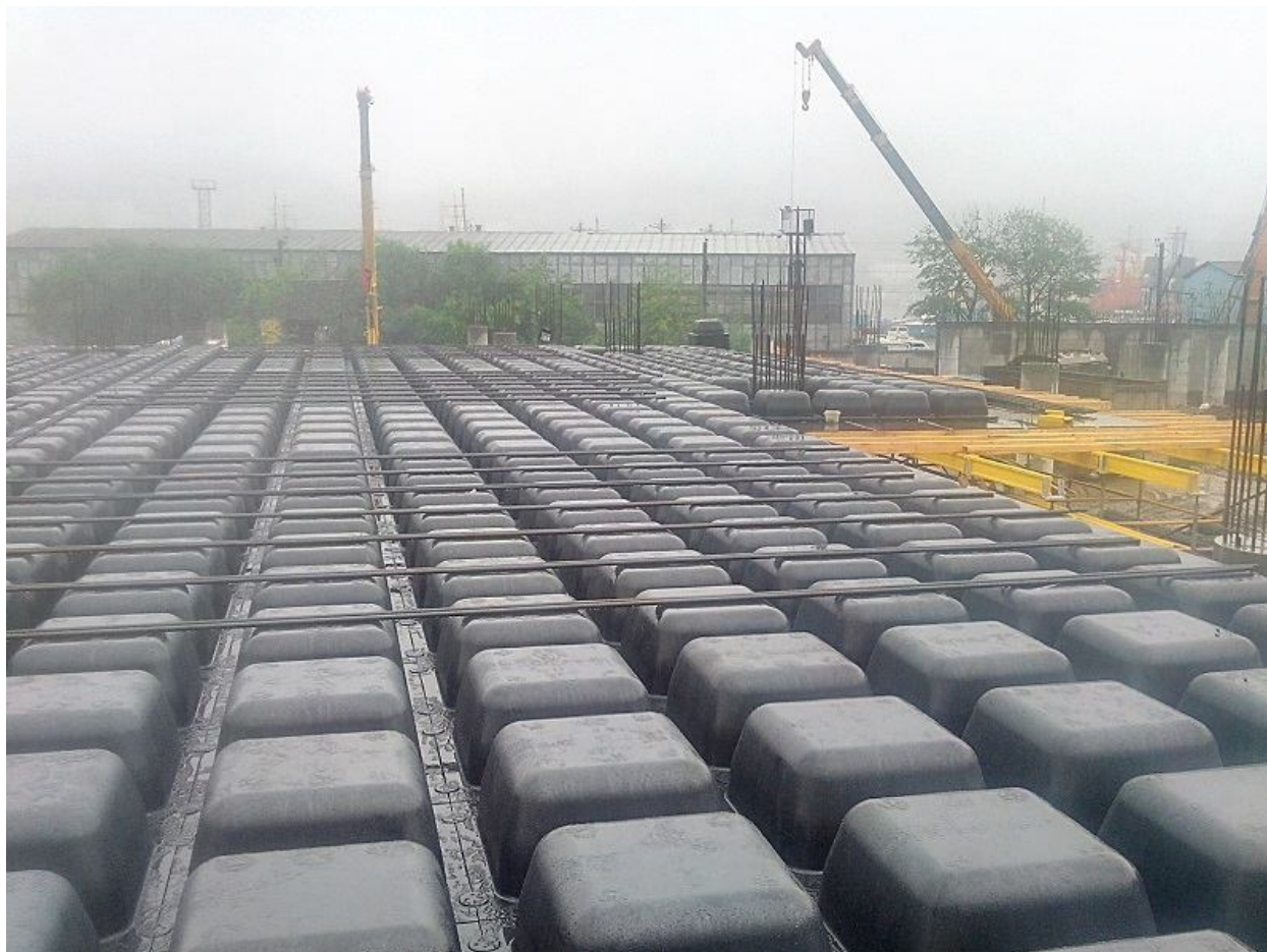
Рис. 2.0. Раскладка корытообразных форм.
