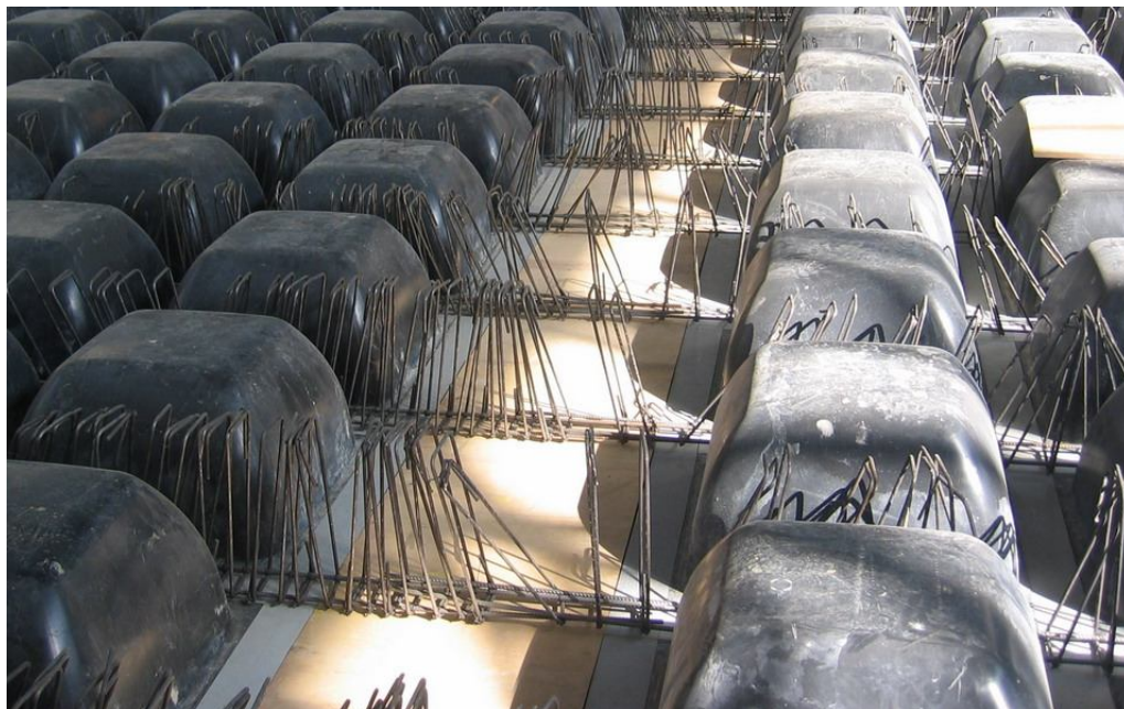
Рис. 3.10. Установка каркасов 1-й очереди.
