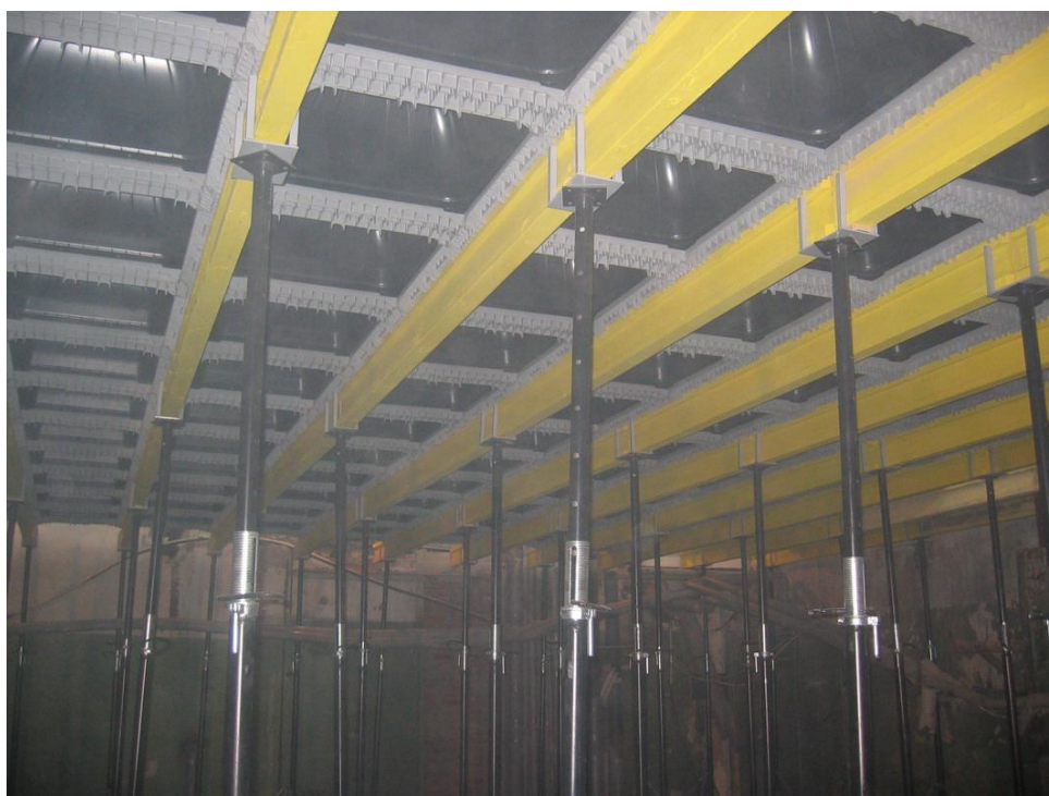
Рис. 3.1. Кессонная опалубка первого типа на примере «SKYDOME» вид снизу.
