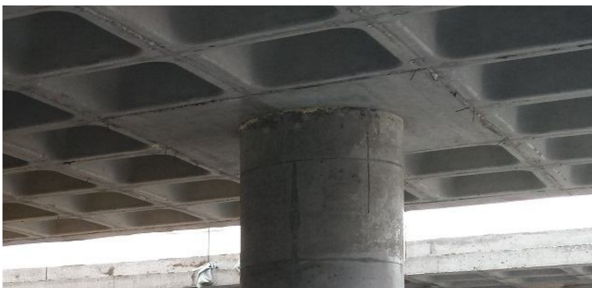
Рис. 2.6. Сплошной монолитный участок у колонны.
