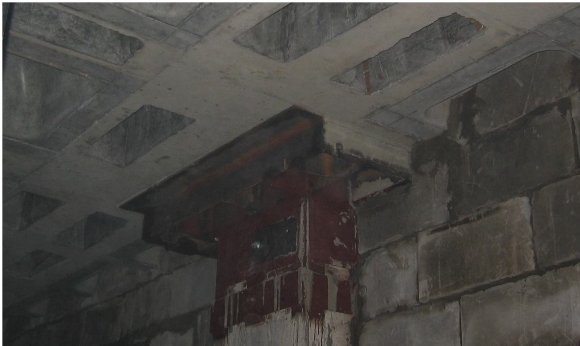
Рис. 2.7. Расположение ребер на опоре в условиях реконструкции.
