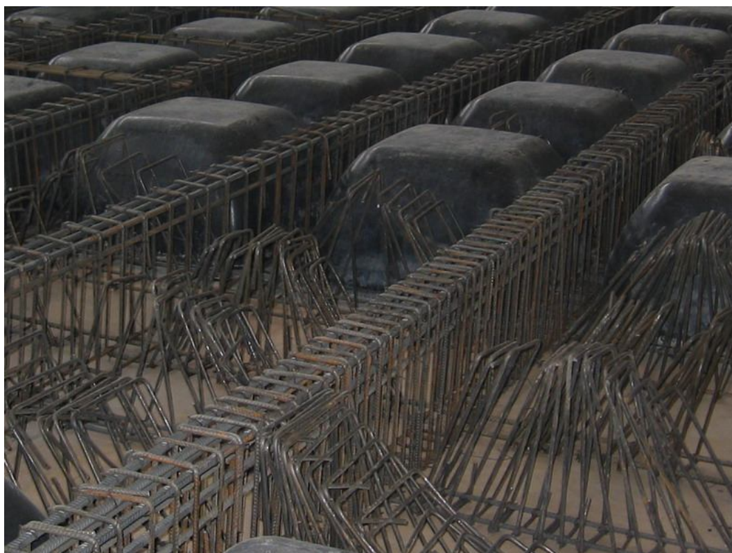
Рис. 3.11. Установка каркасов второй очереди.
