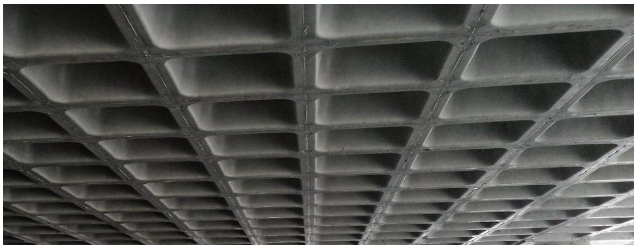
Рис.1.1 Внешний вид облегченного безбалочного перекрытия.
