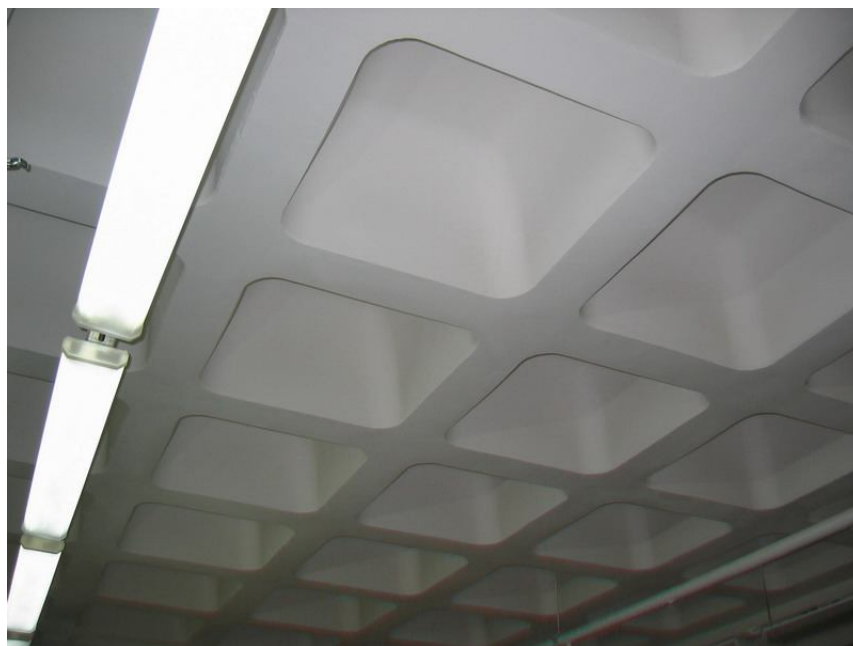
Рис. 3.14. вид кессонного перекрытия при использовании одноразовой картонной опалубки.
