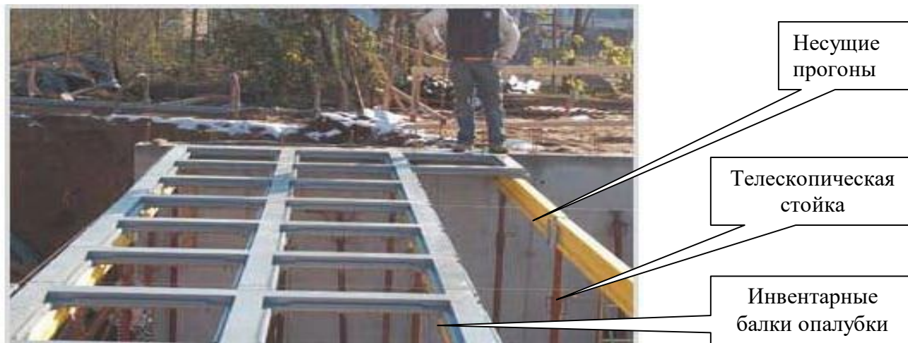
Рис. 3.7. Установка несущих прогонов опалубки по телескопическим стойкам и монтаж инвентарных балок опалубки
