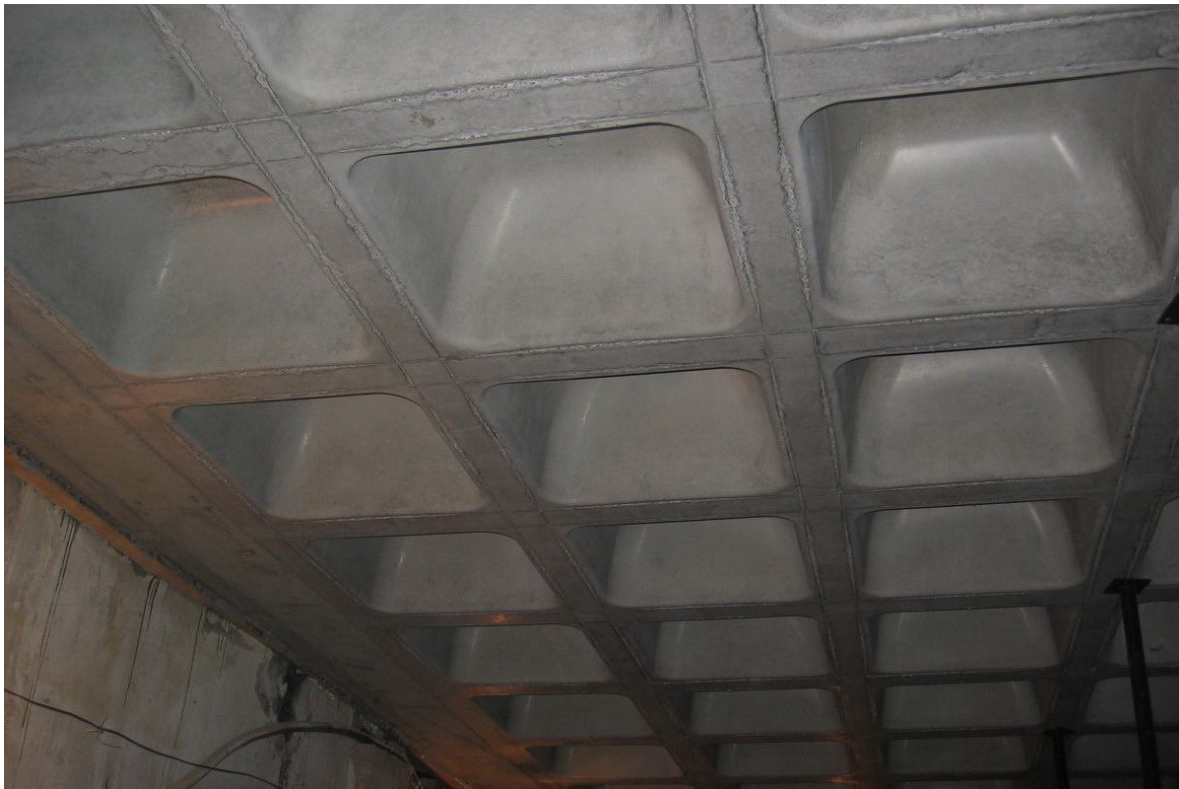
Рис. 2.5. Сплошной монолитный участок у стены.
