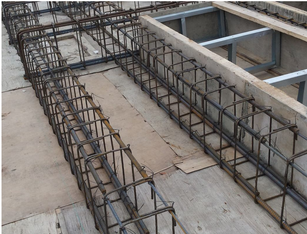
Рис.2.39. Стык нижней и верхней арматуры ребра. Перехлест выполнен больше необходимого по конструктивным соображениям.
