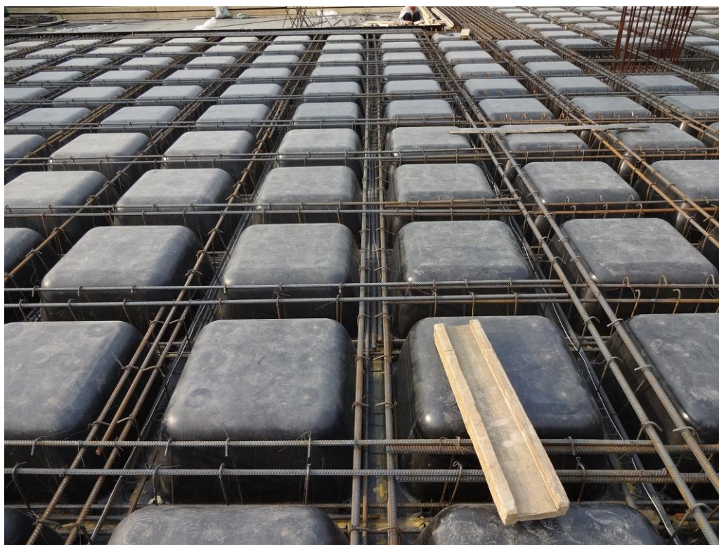
Рис.2.34.1. Расположение поперечной арматуры ребер. Хомуты не замкнутые.
