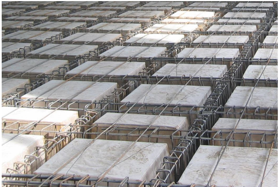
Рис. 3.5. Кессонная опалубка третьего типа с объемными элементами из картона.
